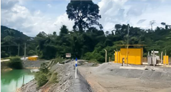
**Figura 2:** Medidor de nível do Sistema de Controle automatizado do SUMP B. Local: Complexo Minerador de Salobo - Marabá/PA
