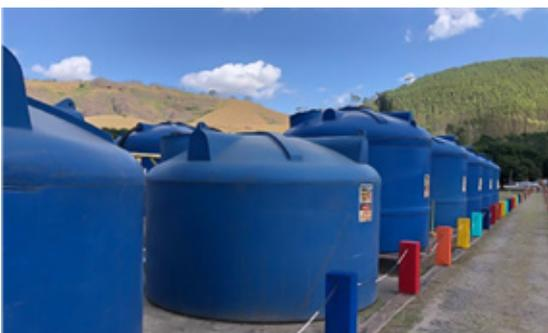
**Figura 2:** Sistema de captação de água de chuva - Oficinas de locomotivas na unidade de Tubarão
