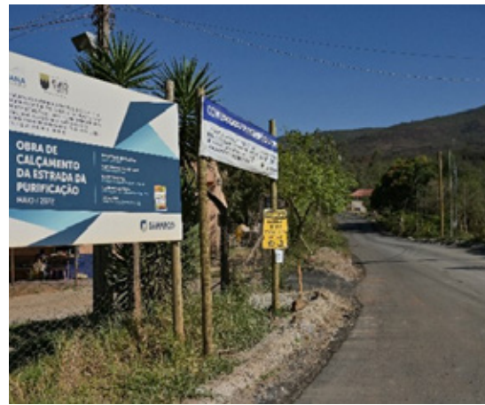
Purificação Road sidewalk works
