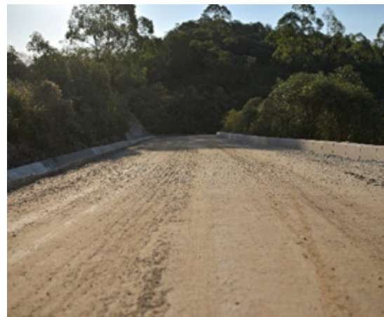
Purificação Road sidewalk works
