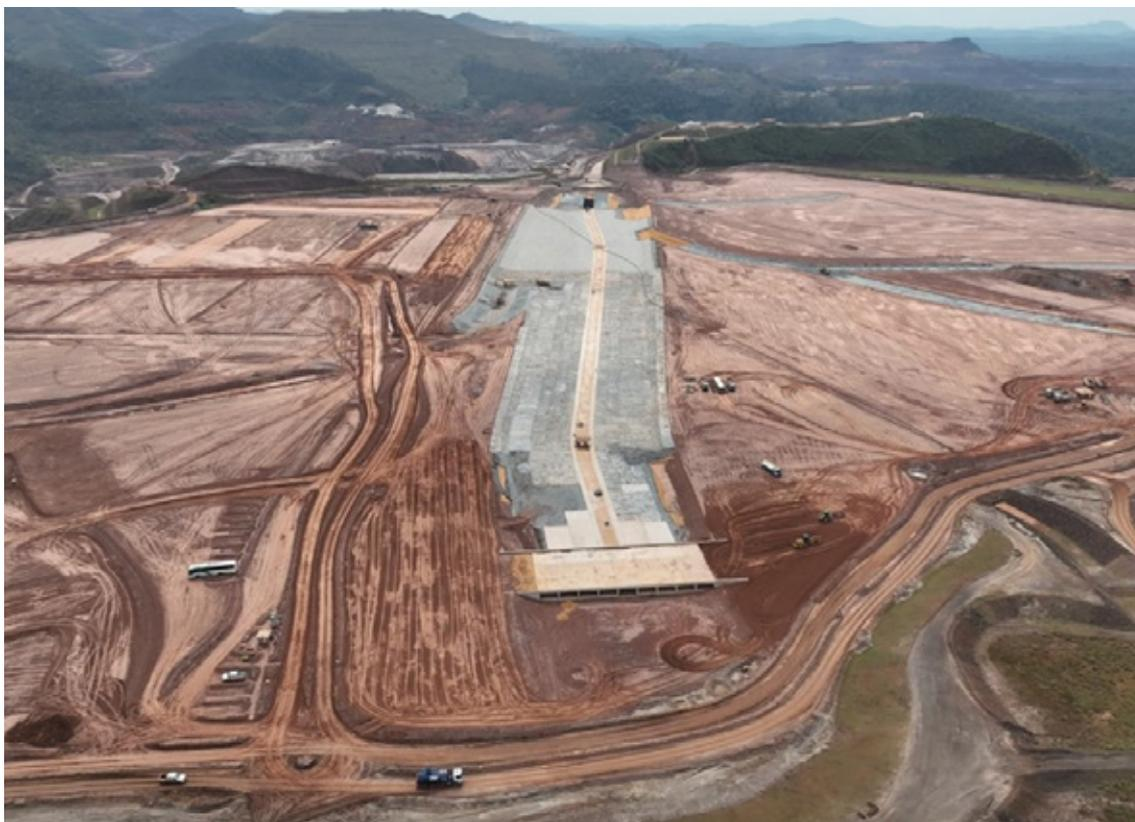
Reconformação do reservatório com rejeito arenoso compactado e implantação do sistema de drenagem superficial.
