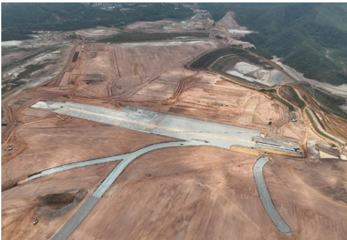
Reconformação do reservatório com rejeito arenoso compactado e implantação do sistema de drenagem superficial.
