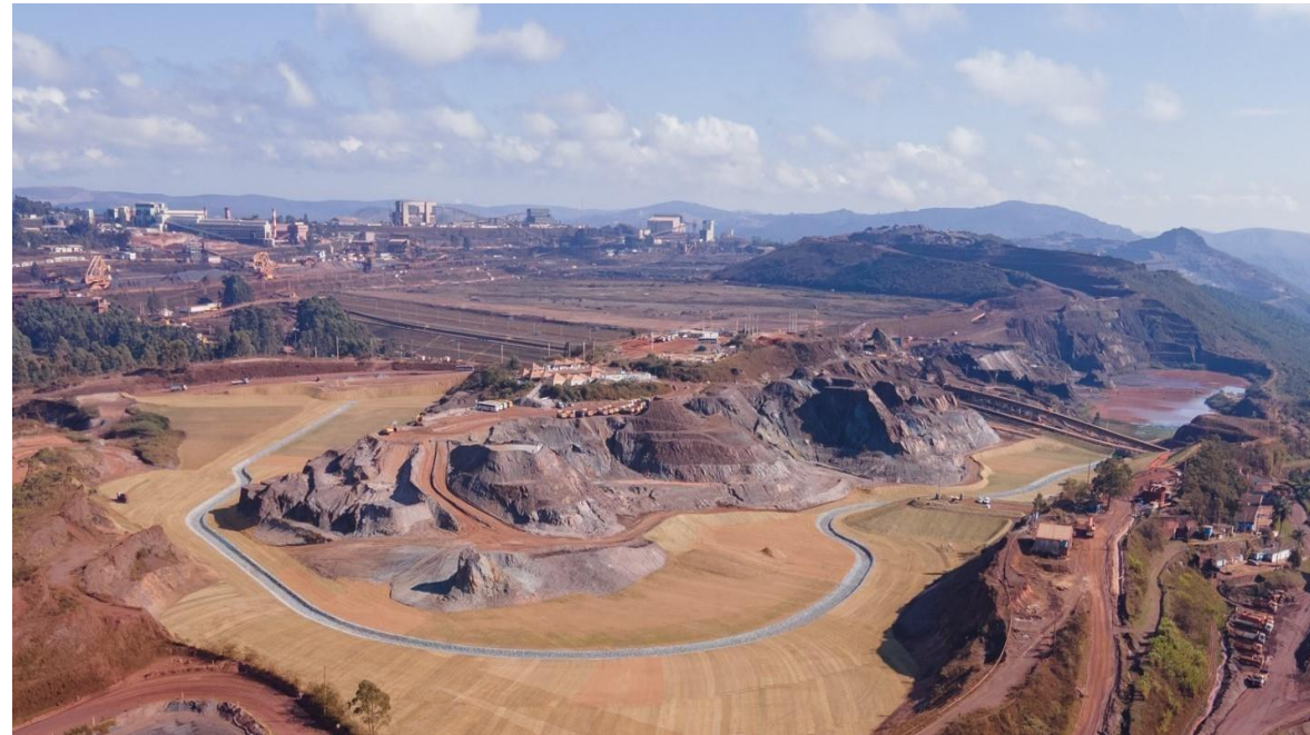
Barragem Fernandinho após o processo de descaracterização. FONTE: Vale.
