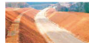
Estabilização de Solo
