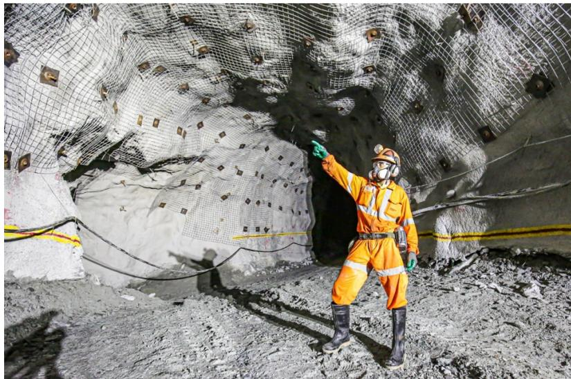
Figura 13 – Galeria de desenvolvimento telada de forma mecanizada
