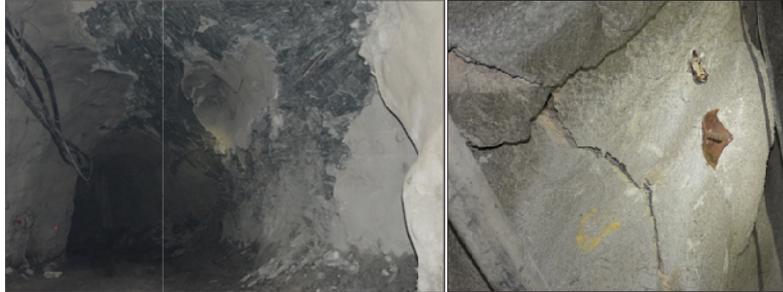
Figura 3: Danos no sistema de suporte observados no subsolo na rampa do Serrotinho – mina Cuiabá (Costa et. al, 2019).
