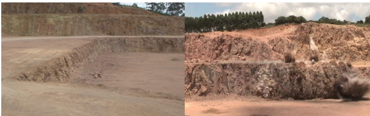
Figura 03 – Área em perfuração e em desmonte de rochas.
