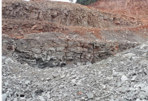
FIGURA 3: Tipos de descontinuidades, suas combinações no maciço e foto ilustrando o fraturamento aberto da rocha
