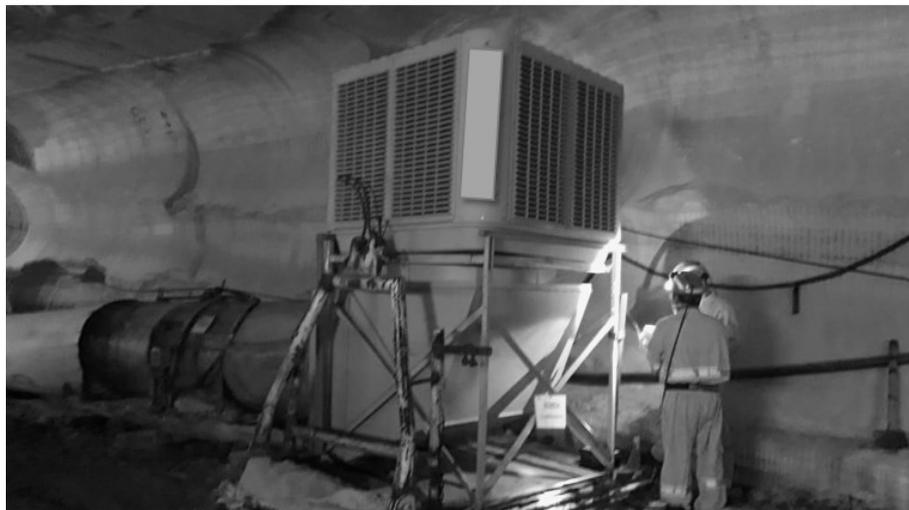
Figura 5- Instalação do climatizador acoplado ao ventilador secundário.
