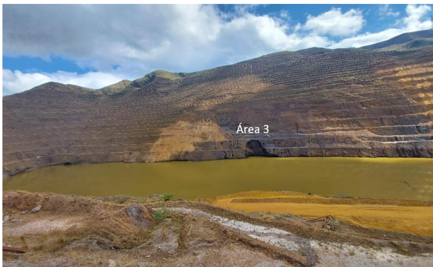
Figura 7: Solapamento na parte inferior da parede norte em março de 2020.
