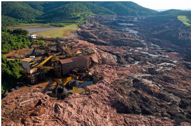
Figura 1: Imagem após a ruptura da Barragem 1.
