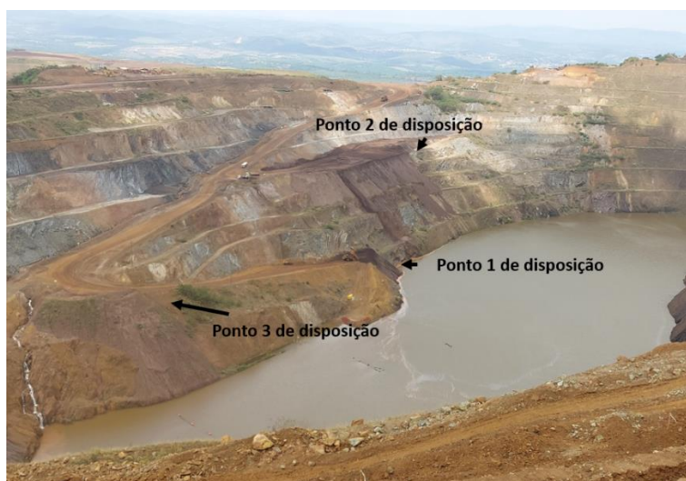
Figura 2: Início da disposição de rejeito nos pontos 1, 2 e 3.
