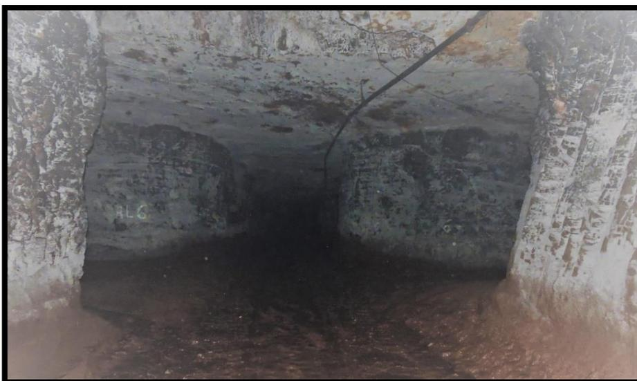
Figura 2 - Foto da geometria típica das galerias (câmaras) e pilares na Mina Urucum.
