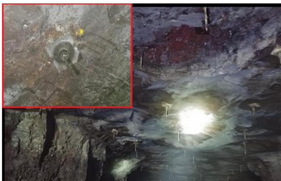
Figura 20 - Malha de contenção adotada na camada MN3 e no detalhe conjunto da instalação chapa/clavete.
