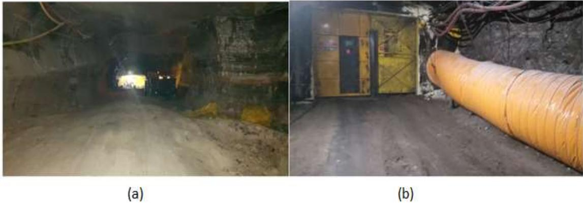
Figura 14- (a) local sem direcionador de fluxo de ar, (b) instalação de porta e reguladores.
