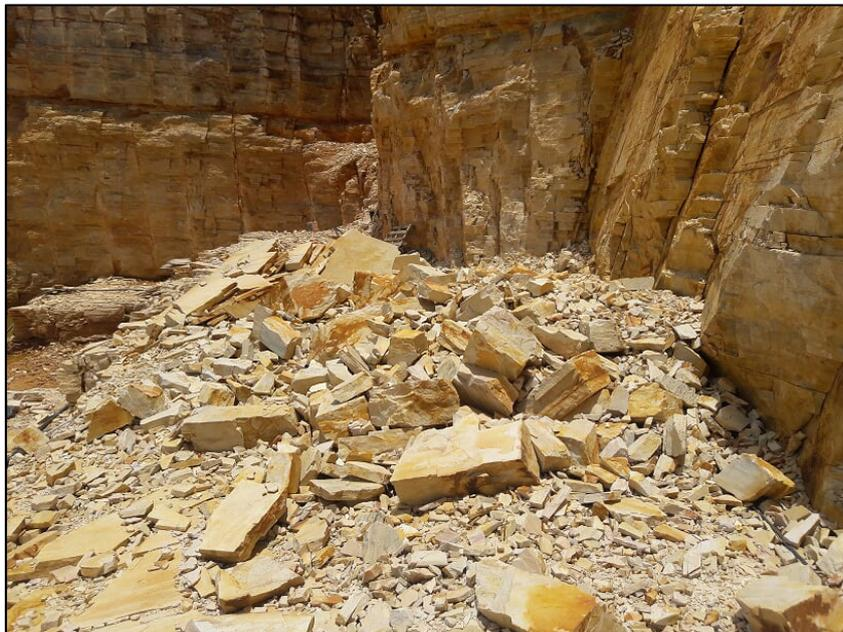
Figura 5: Material rochoso no pé do talude JP1 Face 2 proveniente de deslizamento no talude.
