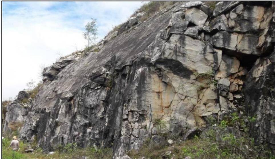
**Figura 11.** Ruptura planar afetando o talude NE1.
