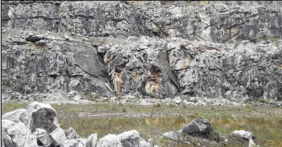
**Figura 9.** Rupturas em cunha afetando o talude NE1.
