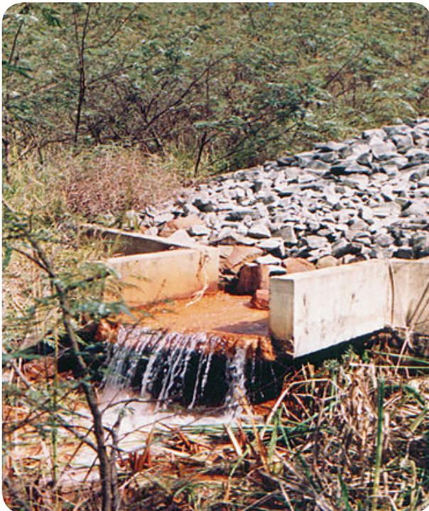
Foto 14. Saída de água por drenagem interna de pilha.
