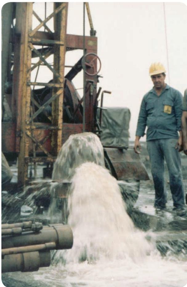
Foto 15. Bombeamento de água subterrânea através de poço tubular profundo.
