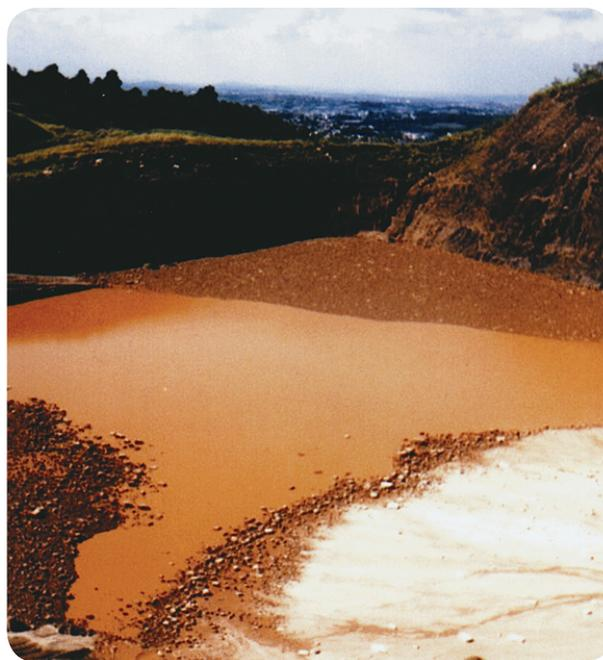
Foto 85. Bacia de contenção e decantação para águas pluviais, mostrando sedimentos aí interceptados
