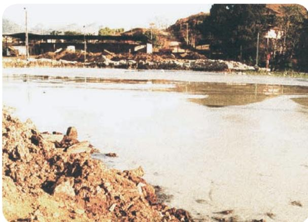
Foto 59. Tanque de deposição final de resíduo de serragem de blocos de rochas ornamentais
