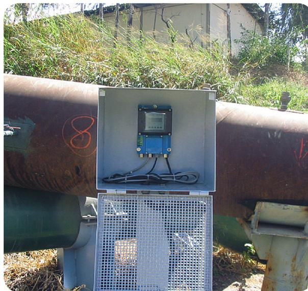
Foto 74. Medidor de Vazão -Tubulação de 30"
