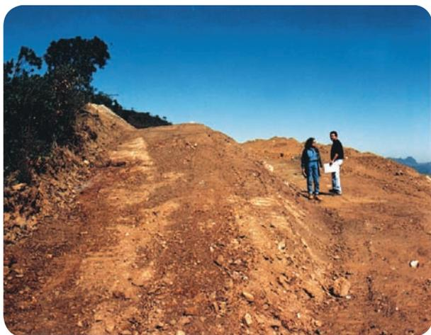
Foto 84. F2 após retaludamento para implantação de drenagem pluvial e, depois, revegetação
