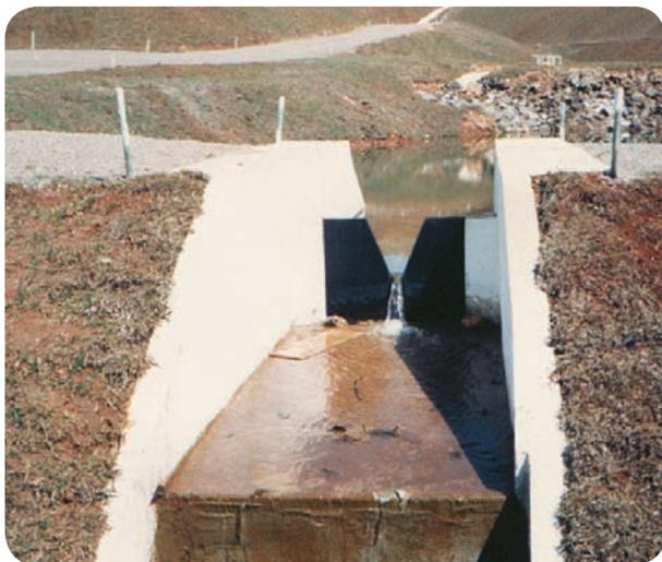
Foto 11. Saída de água a partir de dreno interno do maciço da barragem.
