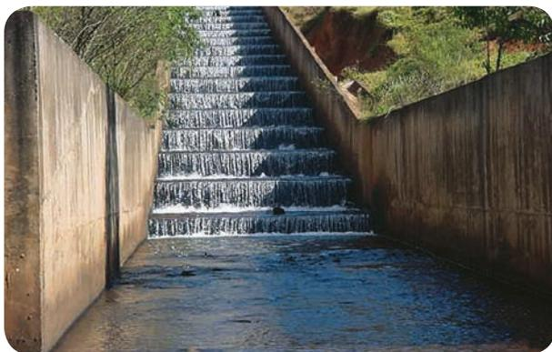
Foto 12. Escoamento de efluente de barragem pelo vertedor.
