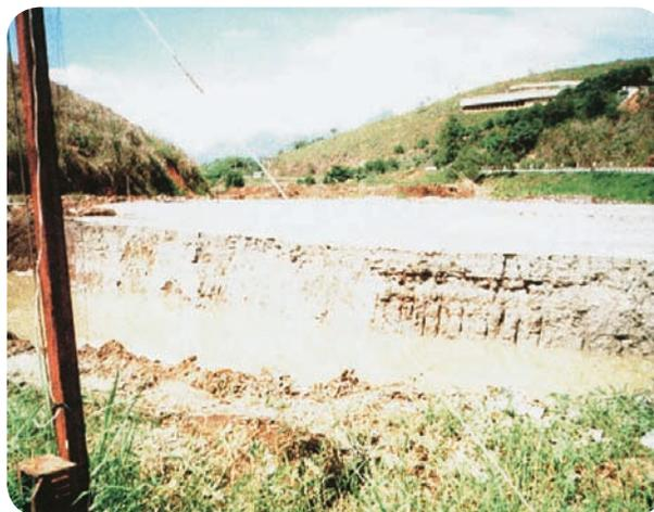
Foto 60. Profundidade do tanque com a lama abrasiva solidificada
