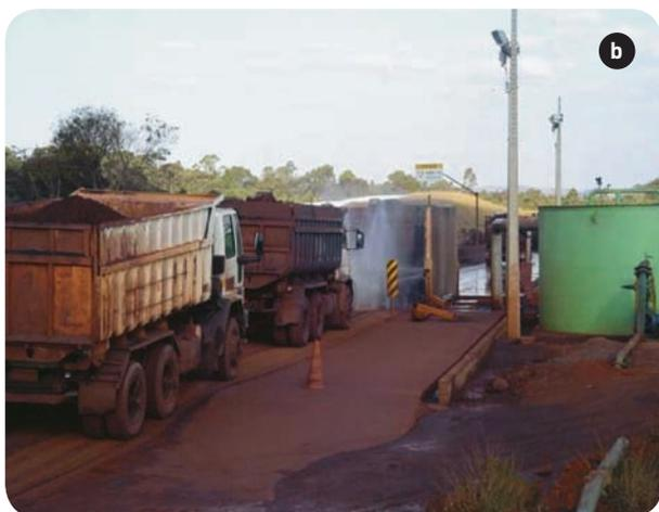
Foto 9 (a,b). Uso de água para lavagem de equipamentos
