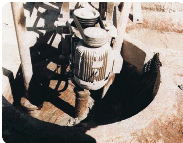
Foto 56. Poço de bombeamento do resíduo para a disposição final
