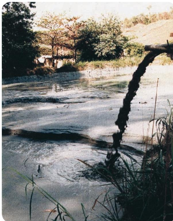
Foto 57. Tanque típico de disposição final do resíduo da serra-gem de blocos de rochas ornamentais (descarte)
