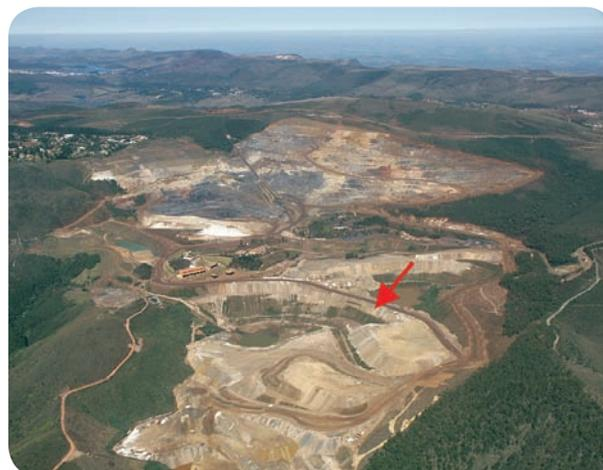
Foto 13. Pilha de estéril em construção a jusante de cava da mina. Fonte: MBR
