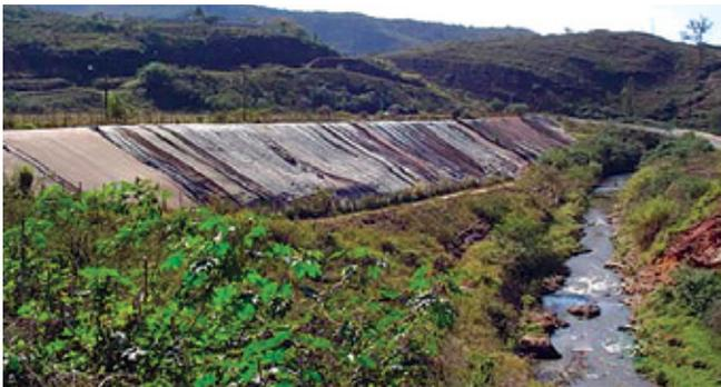
Depósito de rejeitos Galo, à margem do ribeirão Cardoso, em 2004, antes do início dos trabalhos de reabilitação. Note-se o talude coberto por geomembrana de PVC para proteção contra erosão e para evitar o carreamento de rejeitos.
