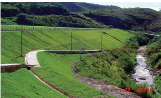
Depósito de rejeitos Galo em 2005, após a conclusão dos trabalhos de reabilitação, observando-se o talude revestido com gramíneas, drenagem de águas pluviais, caminho pedestre e uma nova ponte, solicitada pelos moradores
